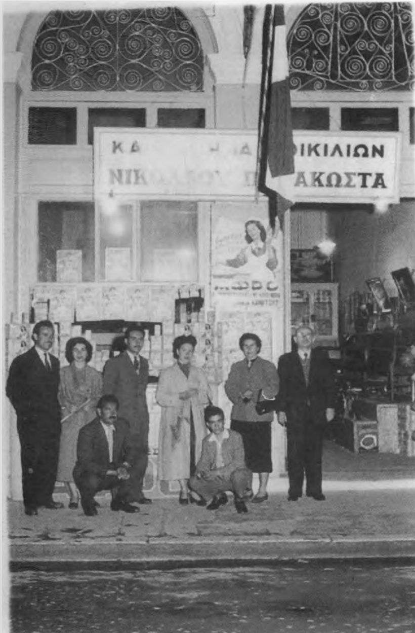
Φωτ. 649 - 651. Η πρόσοψη του κατεδαφισμένου εδώ και χρόνια Στιλβωτηρίου και καταστήματος Ποικιλιών Νικ. Παπακώστα και υιού. Αριστερά η οικογένεια στο πόδι (δεξιά ο ιδρυτής του καταστήματος), ενώ στο βάθος, επάνω δεξιά, φαίνονται αμυδρά οι πολυτελείς για την εποχή τους πολυθρόνες του Στιλβωτηρίου, του μοναδικού για δεκαετίες στην πόλη.
