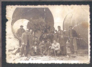
Η εγκατάσταση του αγωγού. The installation of a pipe.
