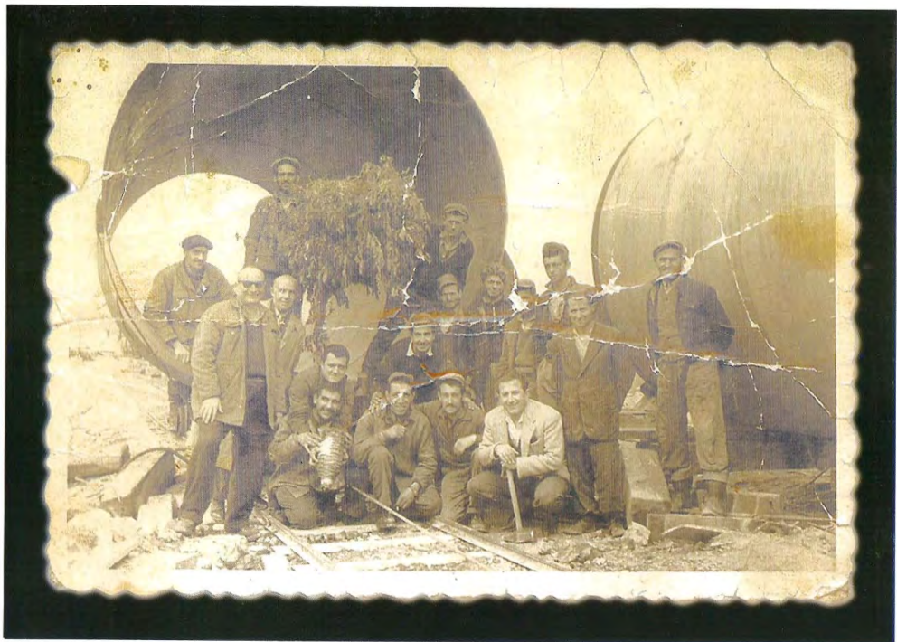
65. Η εγκατάσταση του αγωγού με βαγοτρίλ.
