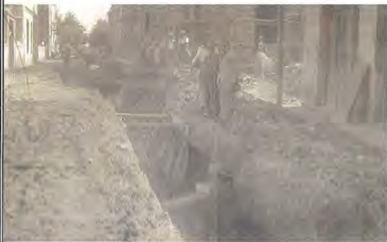
29. Κατασκευή υπονόμων μέσα στην πόλη το 1935.
