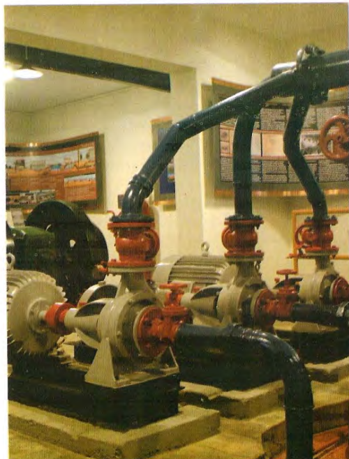
56. Οι τρεις ηλεκτροκινητήρες. Εγκαταστάθηκαν γύρω στο 1965 και εξασφάλιζαν παροχή 60 μ 3 την ώρα ο ένας.
